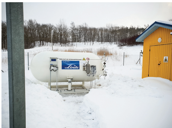
Kunda suletud prügila sai endale uue nõrgveepuhastussüsteemi. Uus CO 2 toimel töötav nõrgveepuhastusjaam on töökindlam, keskkonnasõbralikum ja tõhusam kui eelmine väävelhappe toimel töötanud jaam.
